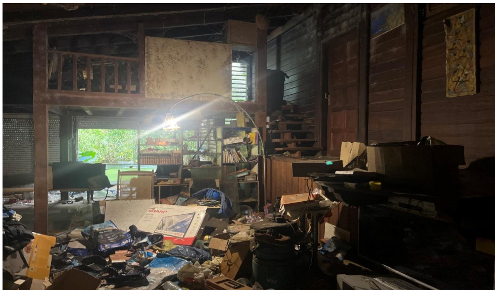
Présence d'un point lumineux avec douille, ampoule et luminaire au plafond.
