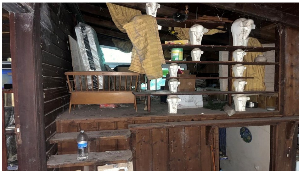
Les sol, murs et plafond sont en bois. La mezzanine est équipée d'une fenêtre coulissante en aluminium.
