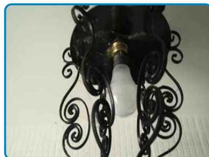
Anomalie B.8.3 b sur Install. n°1
